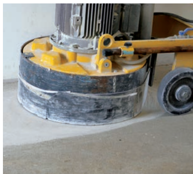
2. Priprava podlage z brušenjem
