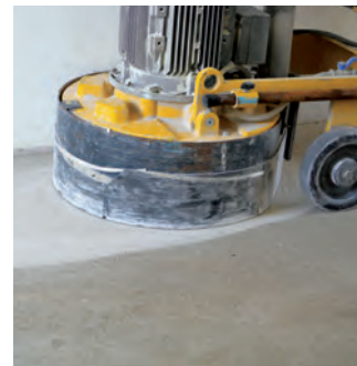
Priprava podlage z brušenjem
