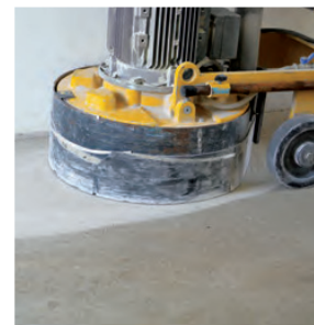
Priprava podlage z brušenjem
