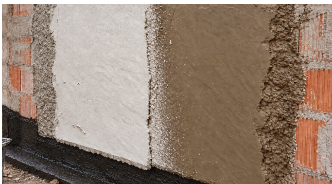
Barvna primerjava nanosa strojnega ometa KEMASAN 550 v beli (levi) in sivi (desno) barvi
