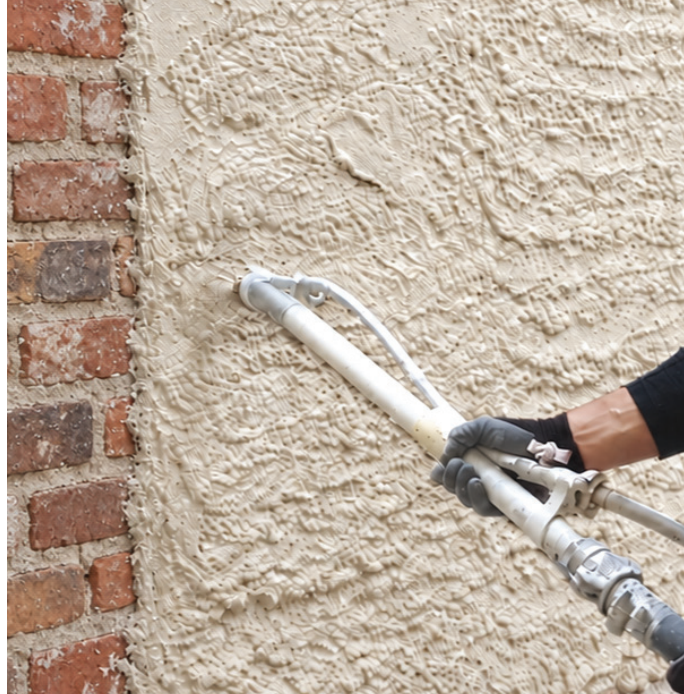
Strojno ometavanje bele različice strojnega ometa KEMASAN 550 MW
